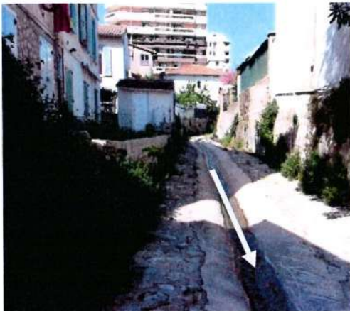
Figure 19 : Photographie du tronçon aérien entre la rue Méricée et le rond-point au droit de la rue Frédéric Mistral et de l'avenue de Lacour
