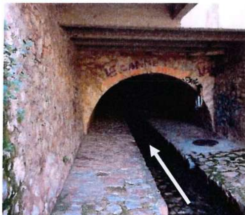
Figure 15 : Photographie de l'ouvrage voûté sous la rue d'Ormesson
