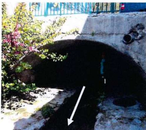
Figure 17 : Photographie de l'ouvrage voûté sous la rue de Cannes
