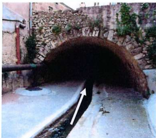
Figure 9 : Photographie de l'entrée de la partie voûtée sous la rue Boucicaut
