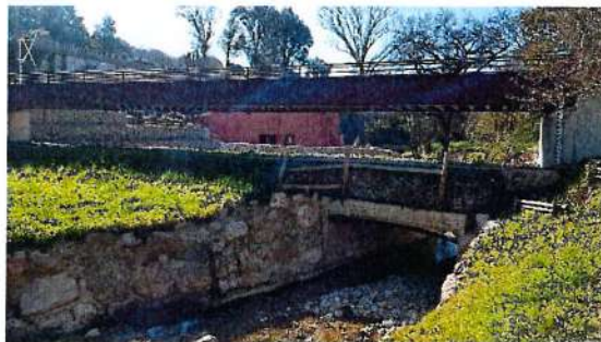
Figure 6 : La Grande Frayère au droit du bassin de rétention du SIFRO
