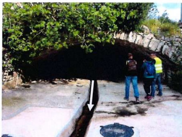
Figure 7 : Photographie de l'ouvrage voûté
