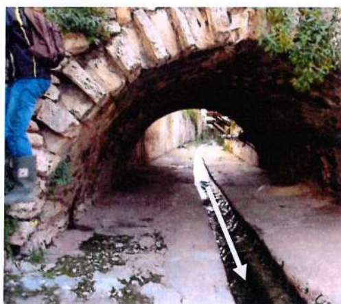
Figure 11 : Photographie de l'ouvrage voûté sous l'avenue de la Baronne
