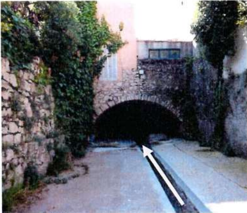
Figure 12 : Photographies de l'ouvrage voûté en aval de l'avenue des Anglais et prise d'étiage
